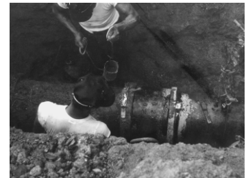
昭和20年代頃の水道管の布設工事の様子
