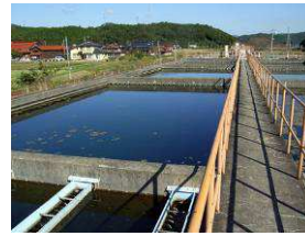
ちん 沈でん池 かものしょうじょうすいじょう (鴨庄浄水場)
