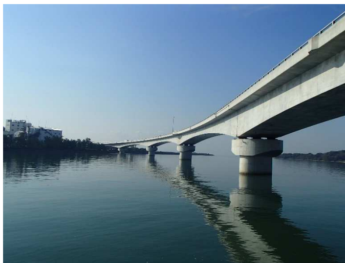
[小野田湾岸道路(有帆川大橋)]
