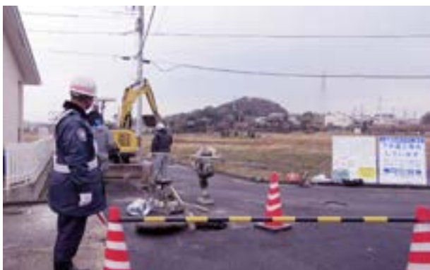
下水道工事現場
