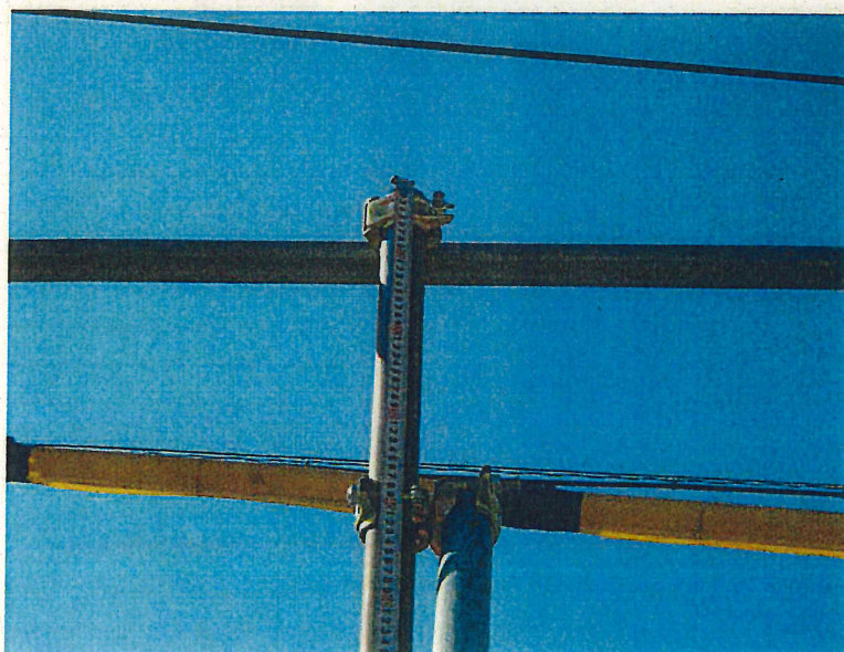
仮設工事 仮囲い地組 H=3.0m
