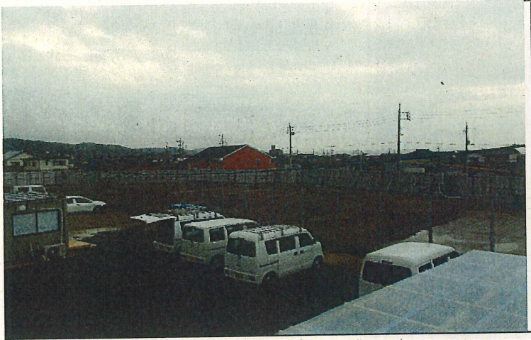
中止期間中現場状況
