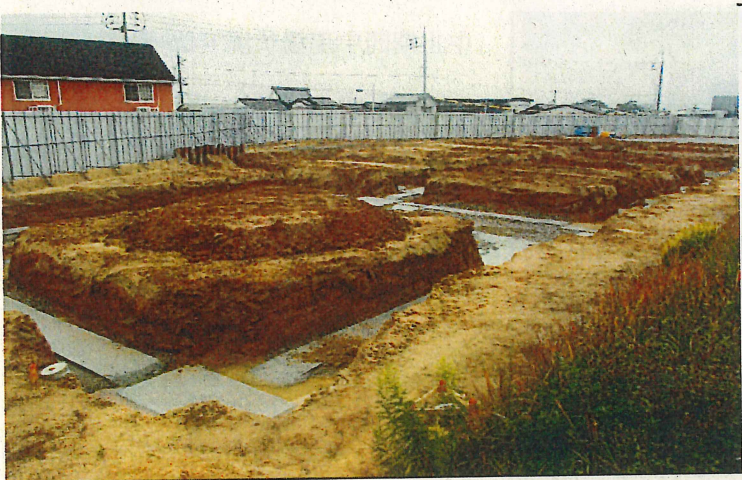
中止期間中現場状況
