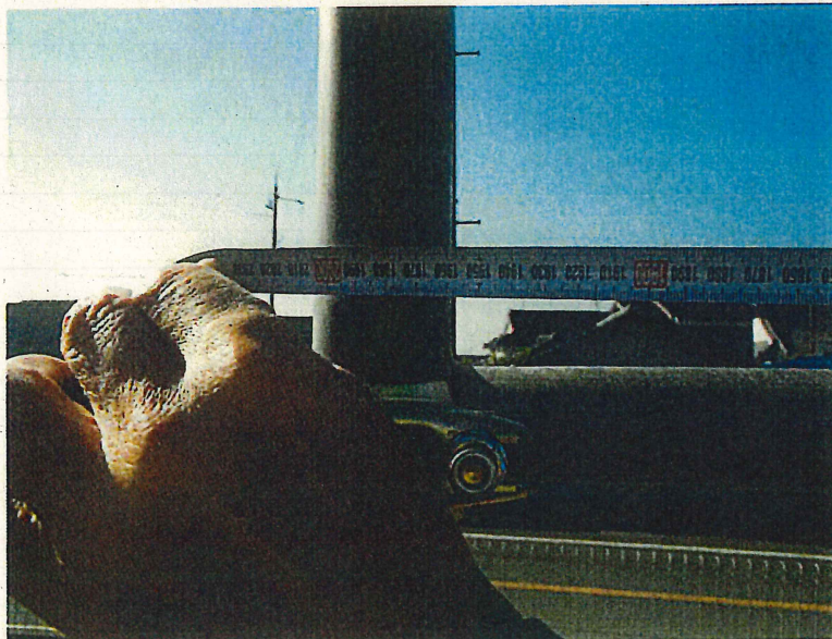
仮設工事 仮囲い地組 H=3.0m
