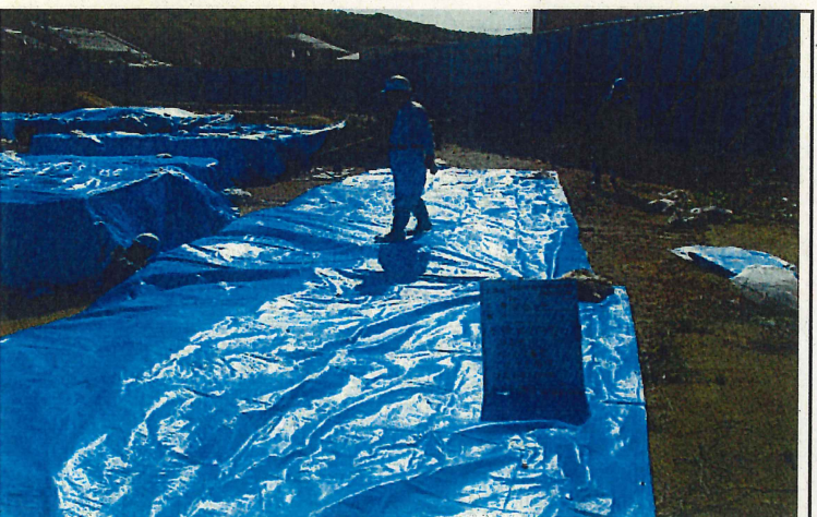
中止期間中現場状況
