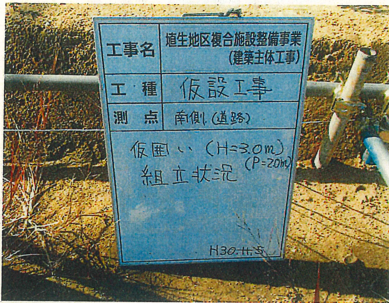
仮設工事 仮囲い地組 H=3.0m
