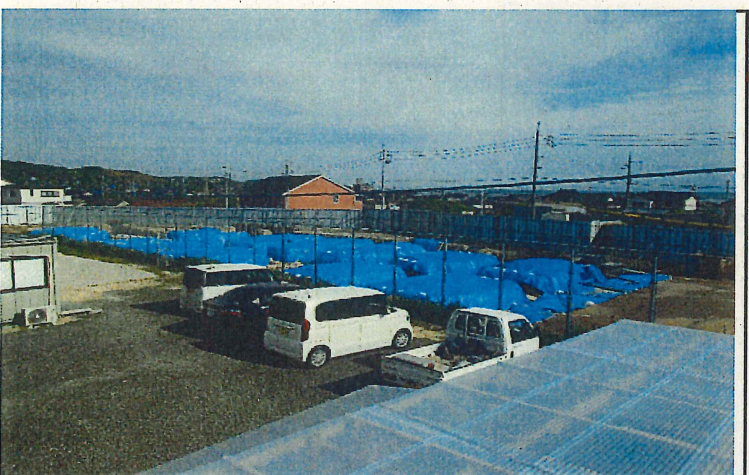
中止期間中現場状況
