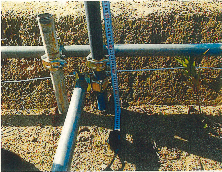
仮設工事 仮囲い地組 H=3.0m
