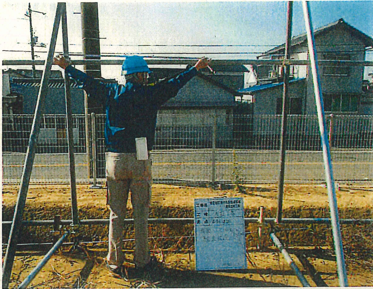
仮設工事 仮囲い地組 H=3.0m
