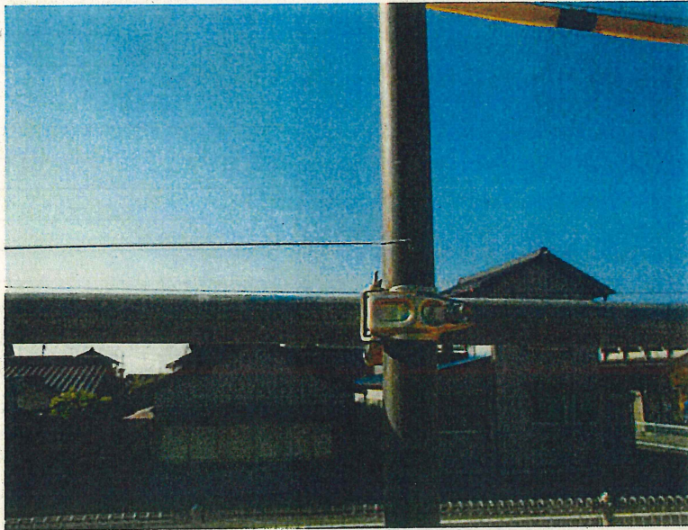
仮設工事 仮囲い地組 H=3.0m
