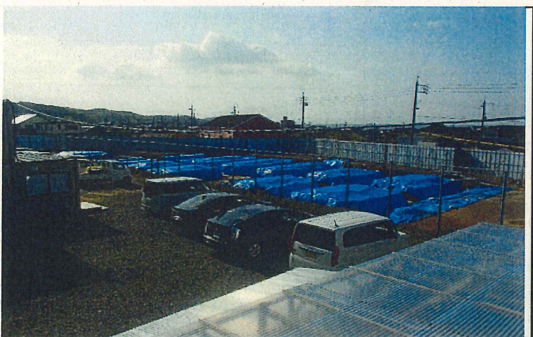
中止期間中現場状況
