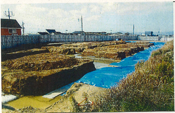
中止期間中現場状況
