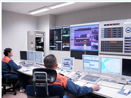
▲万が一の災害に備え、防災情報ネットワークシステムを構築します。(写真は17年度完成の消防緊急通信指令システム)
