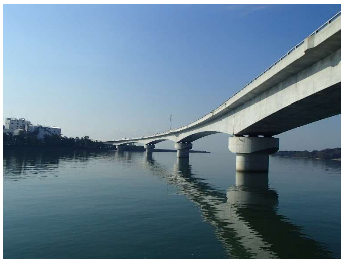
[小野田湾岸道路(有帆川大橋)]
