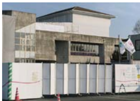
← 改修中の市民館
