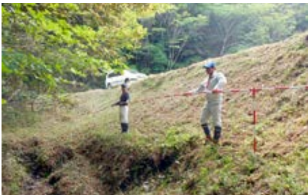
堤体法面が崩れている洗川下ため池
