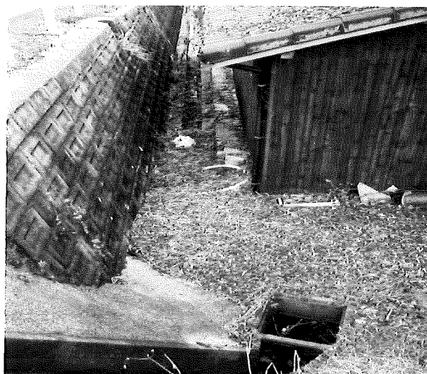
雨水は意図的に右側下の集落へ。左側は旧側溝
