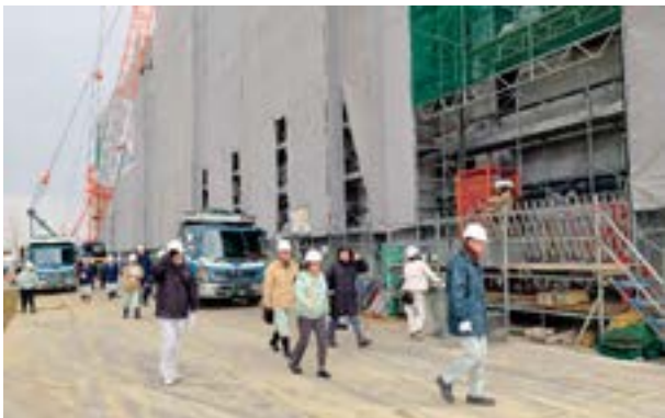
完成が遅れたA棟
