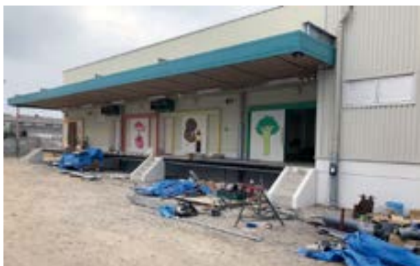
建設中の学校給食センター
