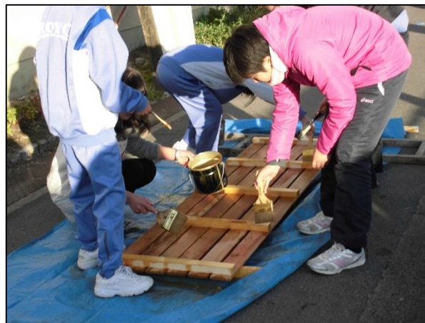
（防腐剤を塗る様子）
