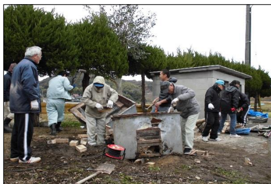
(作業中の様子)
