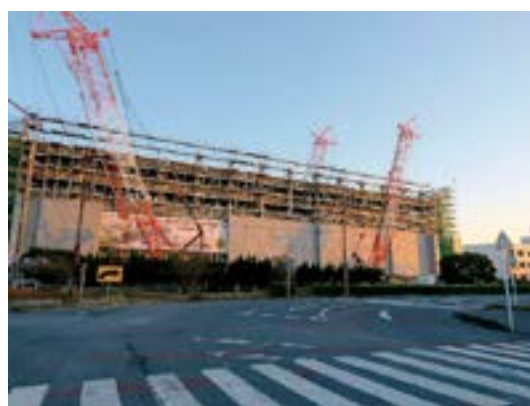
←建設中の薬学部校舎
