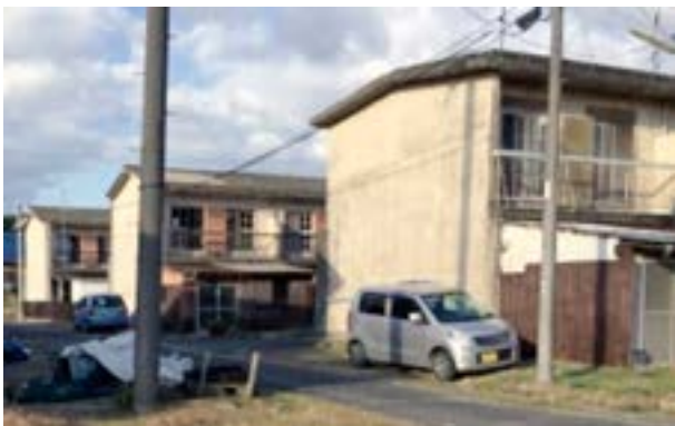
全面的にさら地返還を求められた建物
