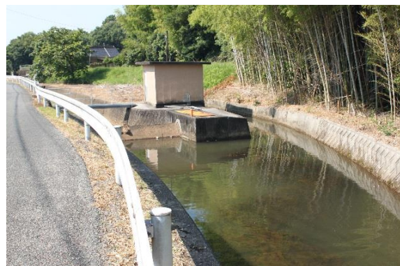
▲現在の茅場分水（上流から）
