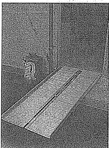
車椅子利用時：折り畳みスロープ設置
