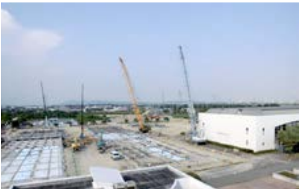
建設中の薬学部校舎
