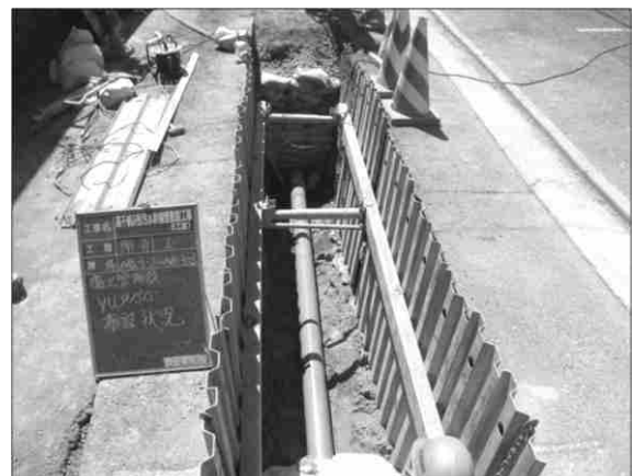
汚水管の埋設
