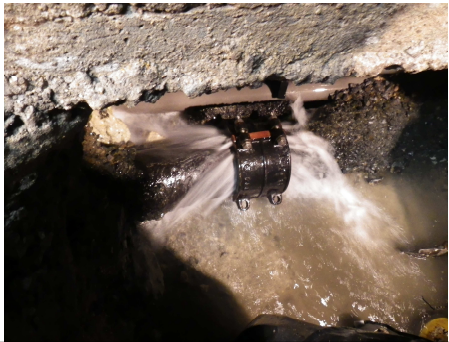
水道管（配水管）の継手部からの漏水を材料にて修繕している状況。 不断水による工法
