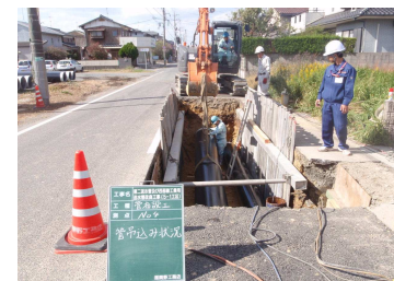
耐震管布設工事
