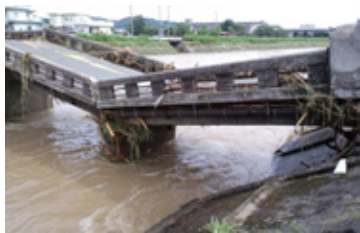
▲破断した水道管(厚狭川新橋)
