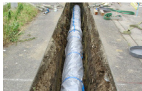
▲老朽化した水道管更新・耐震管布設工事
