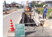
耐震管布設工事
