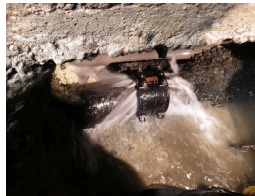
水道管(配水管)の継手部からの漏水を材料にて修繕している状況。不漏水による工法
