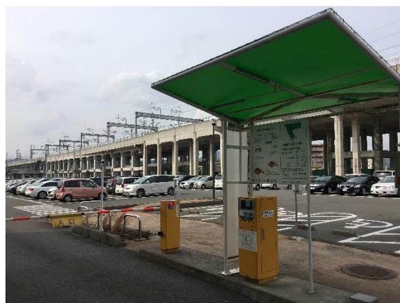
図 31 JR 厚狭駅前前の駐車場の整備状況
