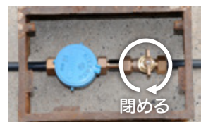
メーターボックス(左:メーター 右:止水栓)▲
