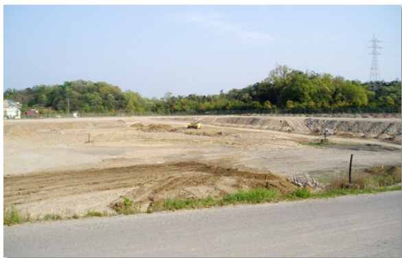
有帆緑地処分場
