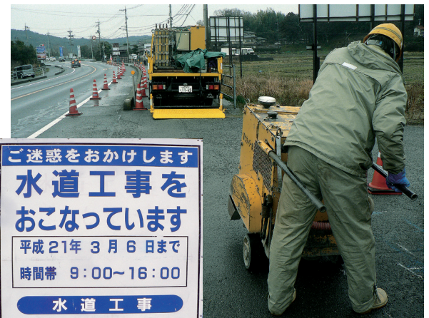
小野田地区と山陽地区をつなぐ 水道連絡管工事
