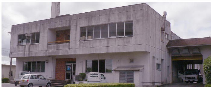
老朽化している山陽浄化センター
