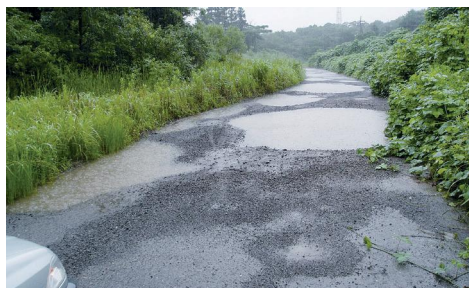
大谷地区道路 (千崎線側)
