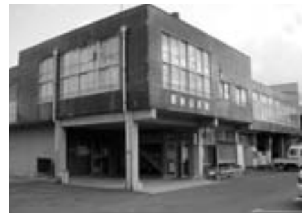
老朽化した厚狭公民館
