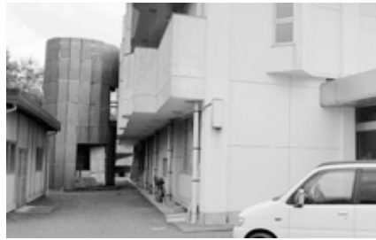
使用不能の避難通路をスロープへ
