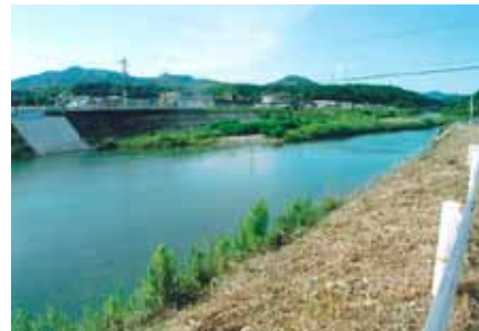
撤去された新橋付近
