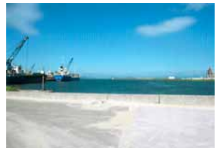
しゅんせつ工事が始まる小野田港湾
