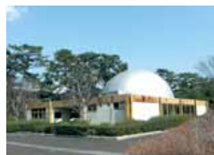
改修が必要な天文館
