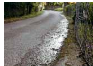
生活排水が道に流れ出している
