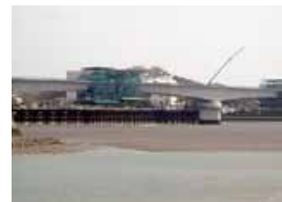
新有帆架橋工事
