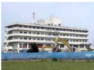
建て替え中の市民病院
