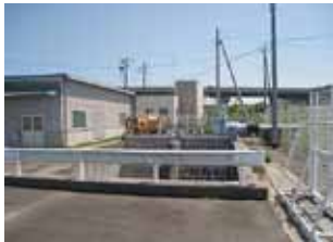
東下津排水機場
