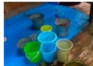
雨漏りのする厚狭公民館
