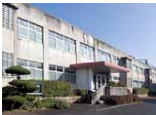
耐震工事が必要な 埴生小学校
