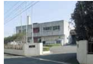
山陽浄化センター
