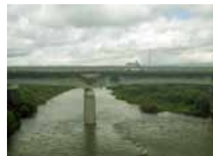
厚狭川改修工事
