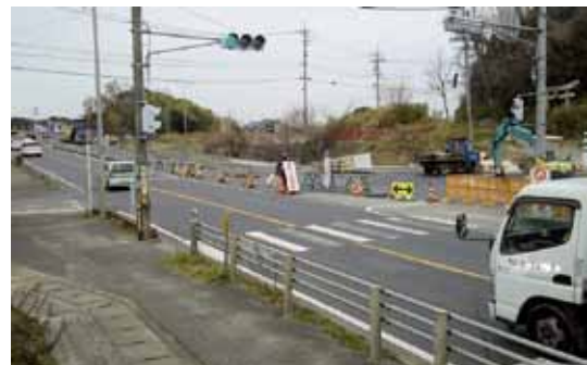
↑ 工事中の市道千代町高砂線
