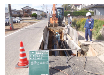
耐震管布設工事
