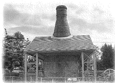
「国指定文化財」 旧小野田セメント製造株式会社竪窯
