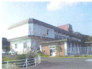
たかまがはらじょうすいじょう 高天原浄水場
