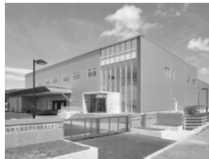
長野県松本市東部給食センター
