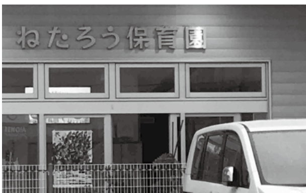
昨年新築開園し2年連続して浸水
