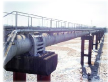
【厚東川水管橋】
