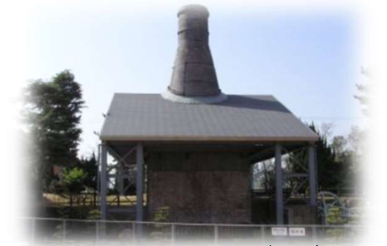
旧小野田セメント徳利窯 (国指定重要文化財・県指定有形文化財)
