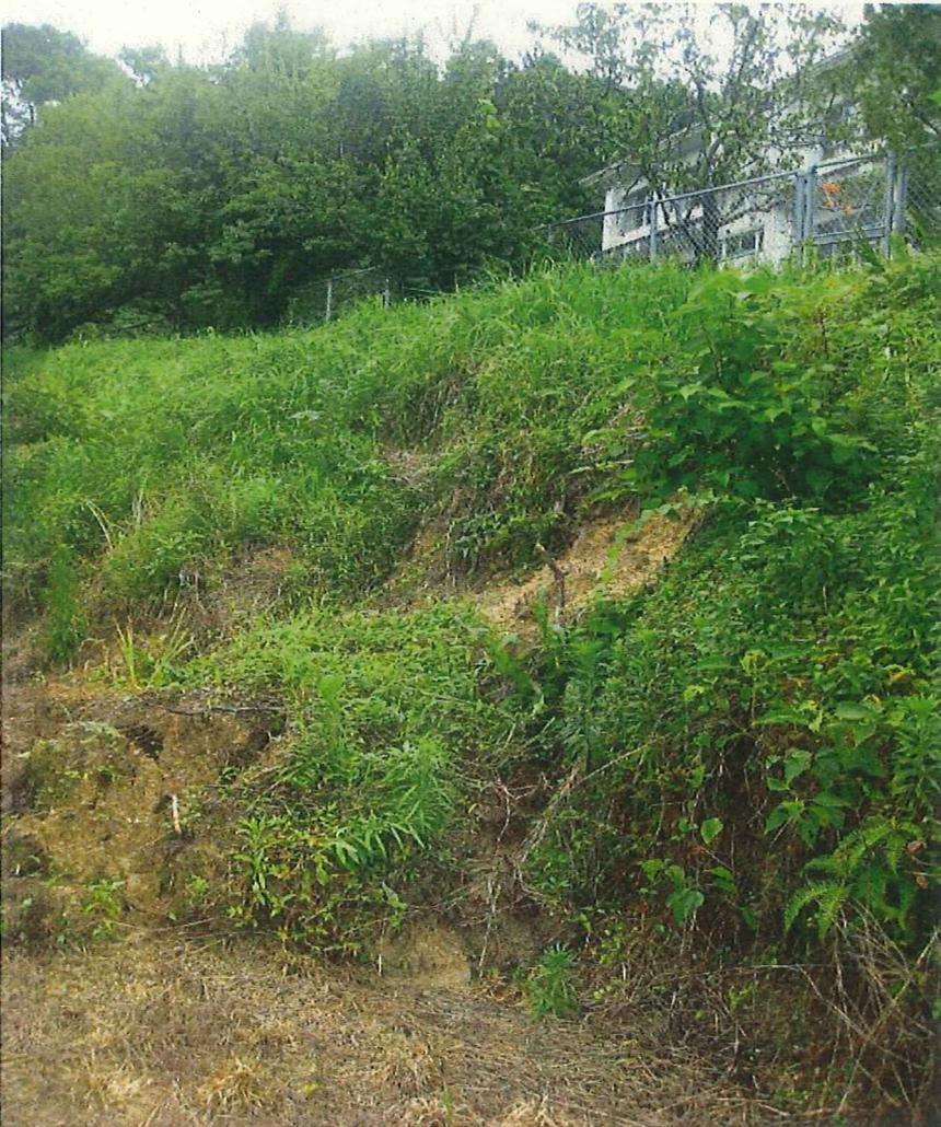
●高泊小学校北側法面崩落②校舎奥側(縦7.5m×横14m)
