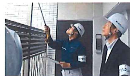
■建物重点点検
