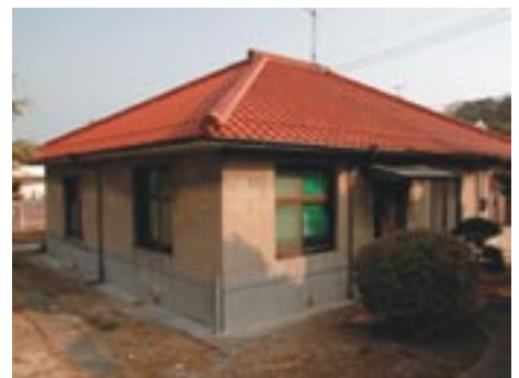
▲「セメント住吉社宅」は旧小野田セメントの役員社宅として大正13年に建築されました。オレンジ色の瓦が特徴です。
