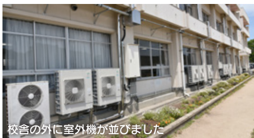
小学校の教室にエアコンを設置
