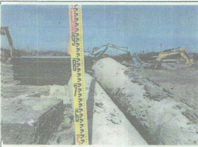
山口東京理科大学薬学部増築工事 B棟建築主体工事
