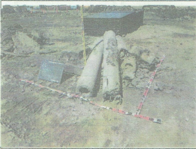
山口東京理科大学薬学部増築工事 B棟建築主体工事
