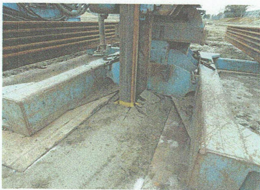
鋼矢板土留め 高止まり状況確認
