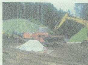
浅層混合(M'ック)工法
