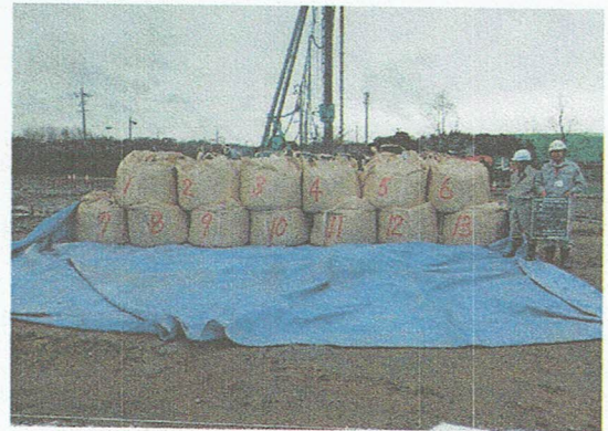
地盤改良土留め 材料受入検査
