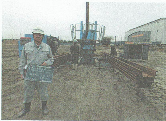
鋼矢板土留め 圧入状況確認
