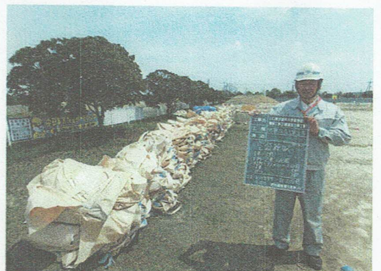
地盤改良土留め 固化材空袋確認
