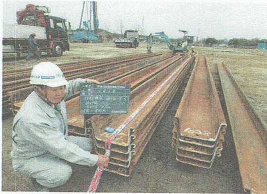
鋼矢板土留め 材料受入検査
