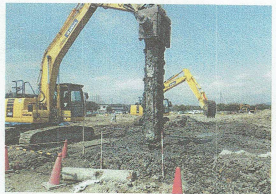
地盤改良土留め 固化材攪拌状況確認
