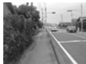
安心・安全な通行が確保された歩道
