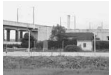
山陽浄化センター
