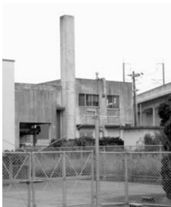
山陽浄化センター
