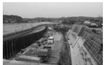
前場川改修工事
